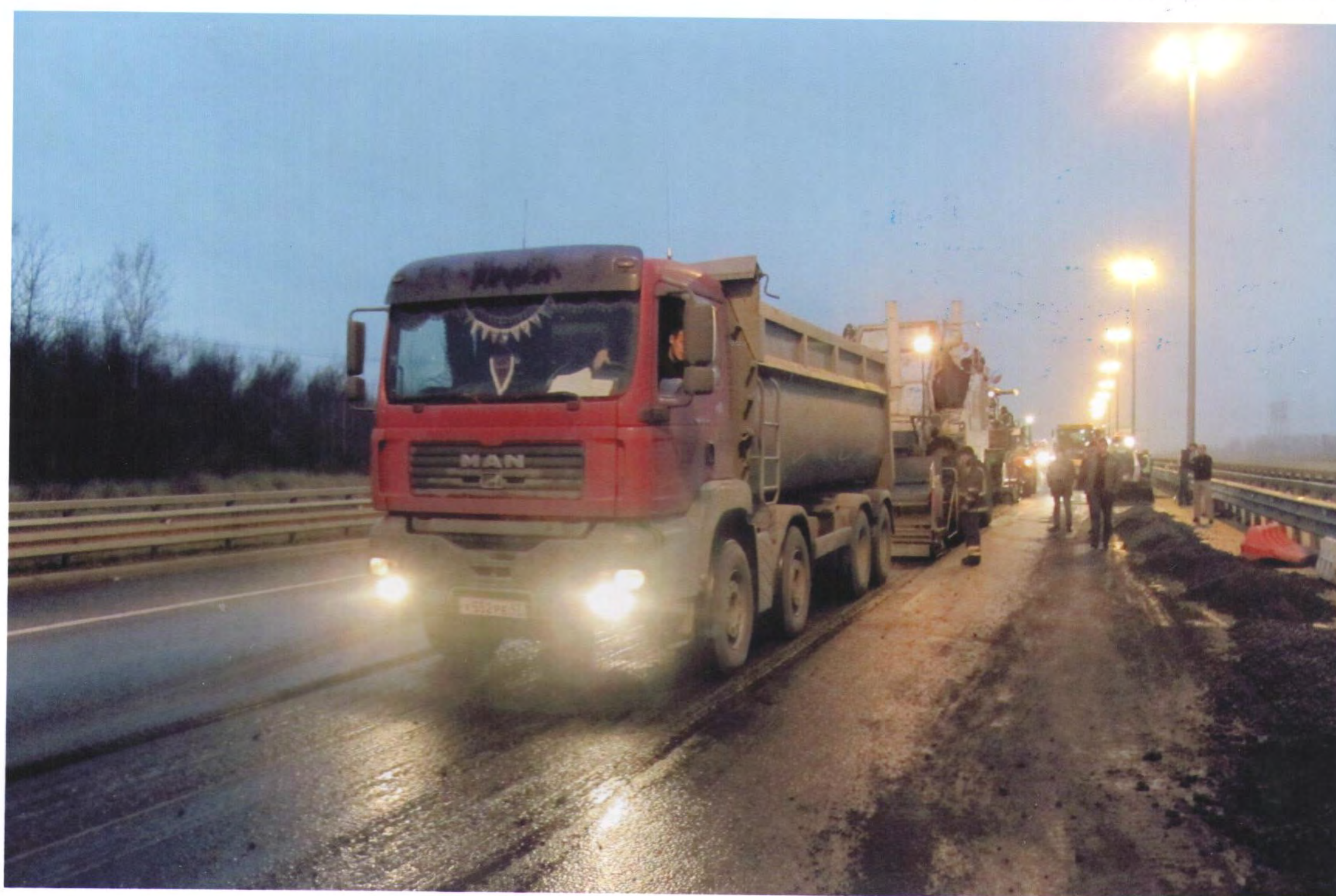
Рис. 5 Доставка опытной партии асфальтобетонной смеси на объект
