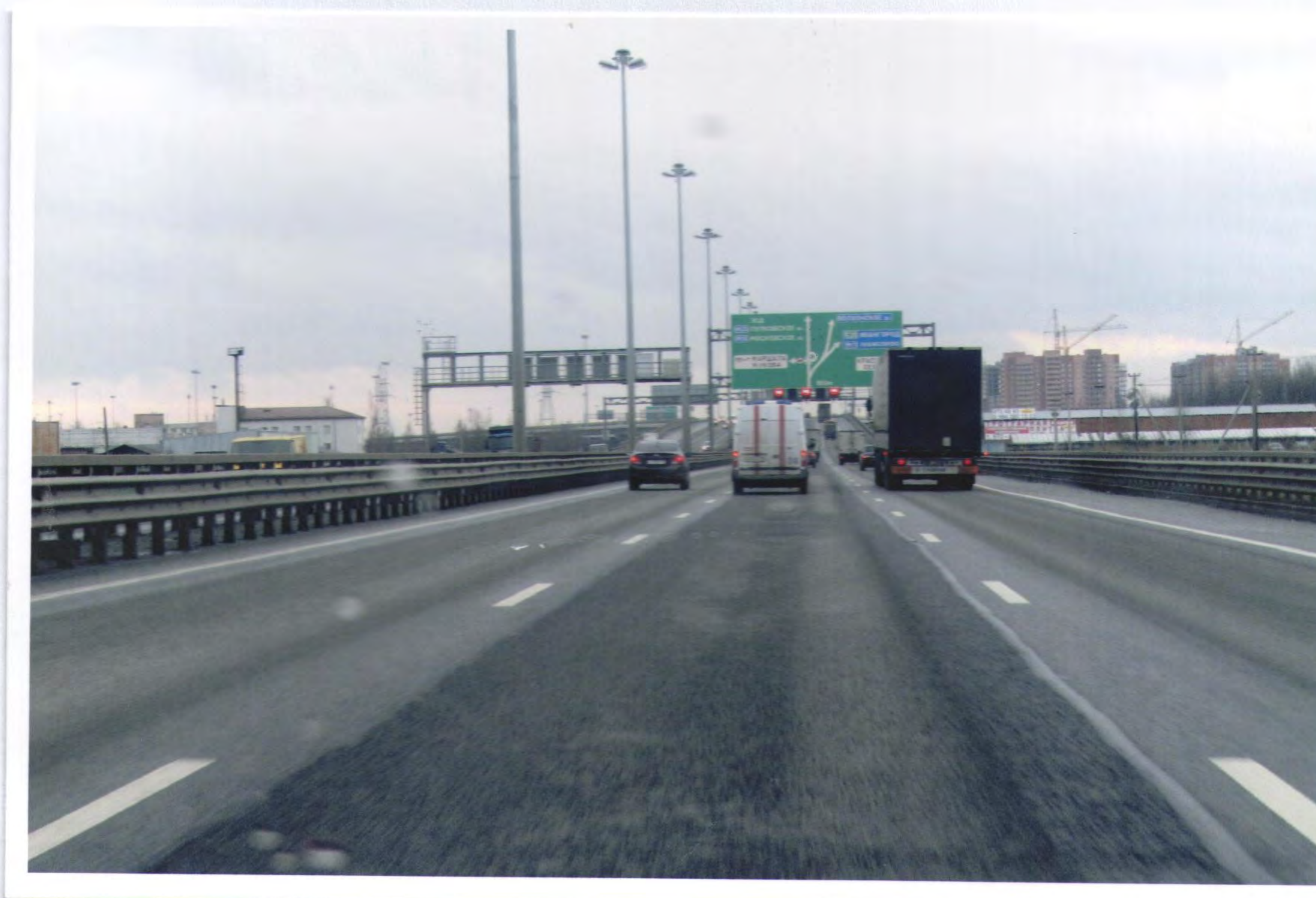
Рис. 18 Общий вид опытного участка асфальтобетонного покрытия через 7 дней эксплуатации
