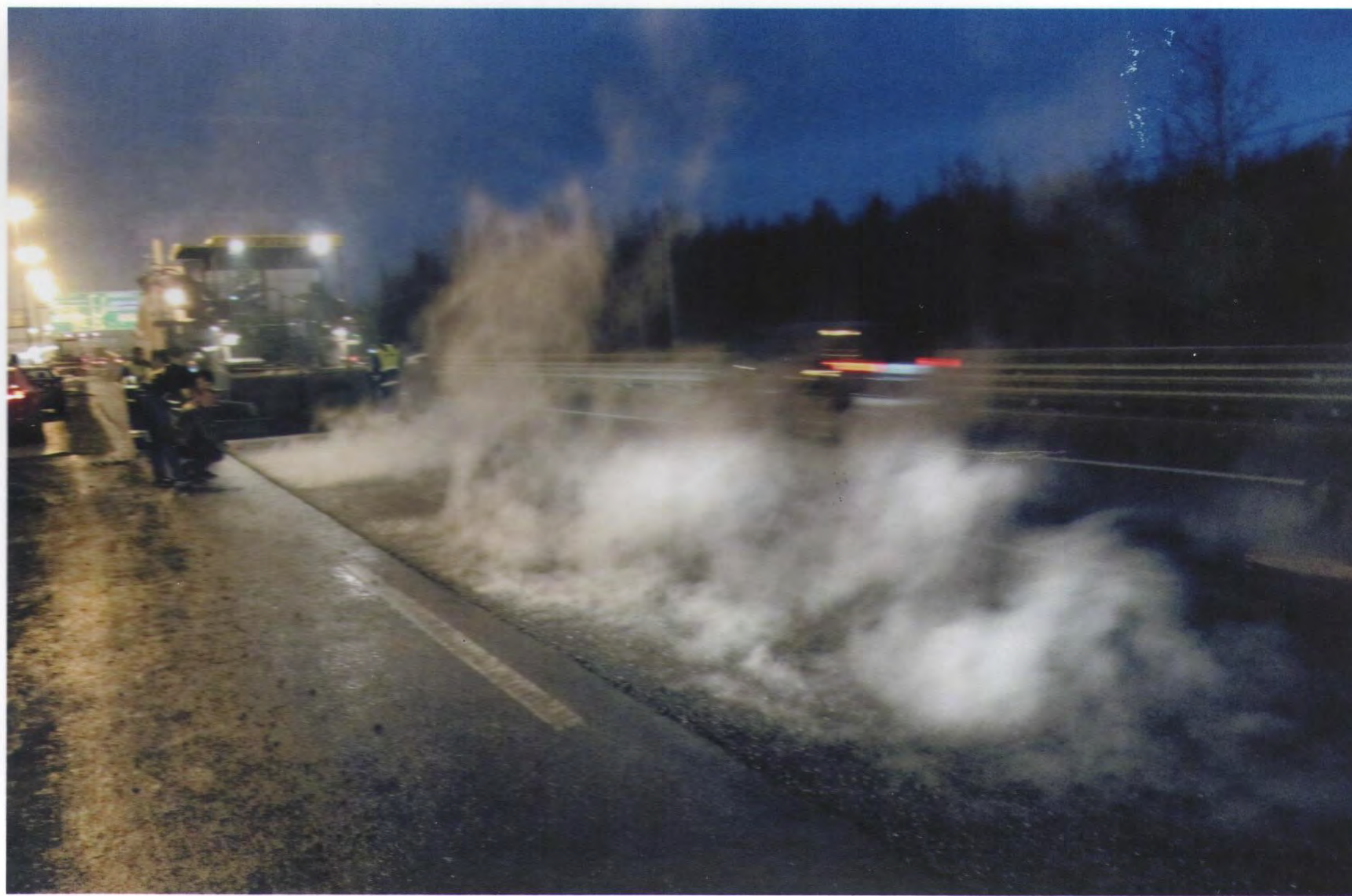
Рис. 14 Общий вид поверхности слоя асфальтобетонного покрытия при уплотнении смеси
