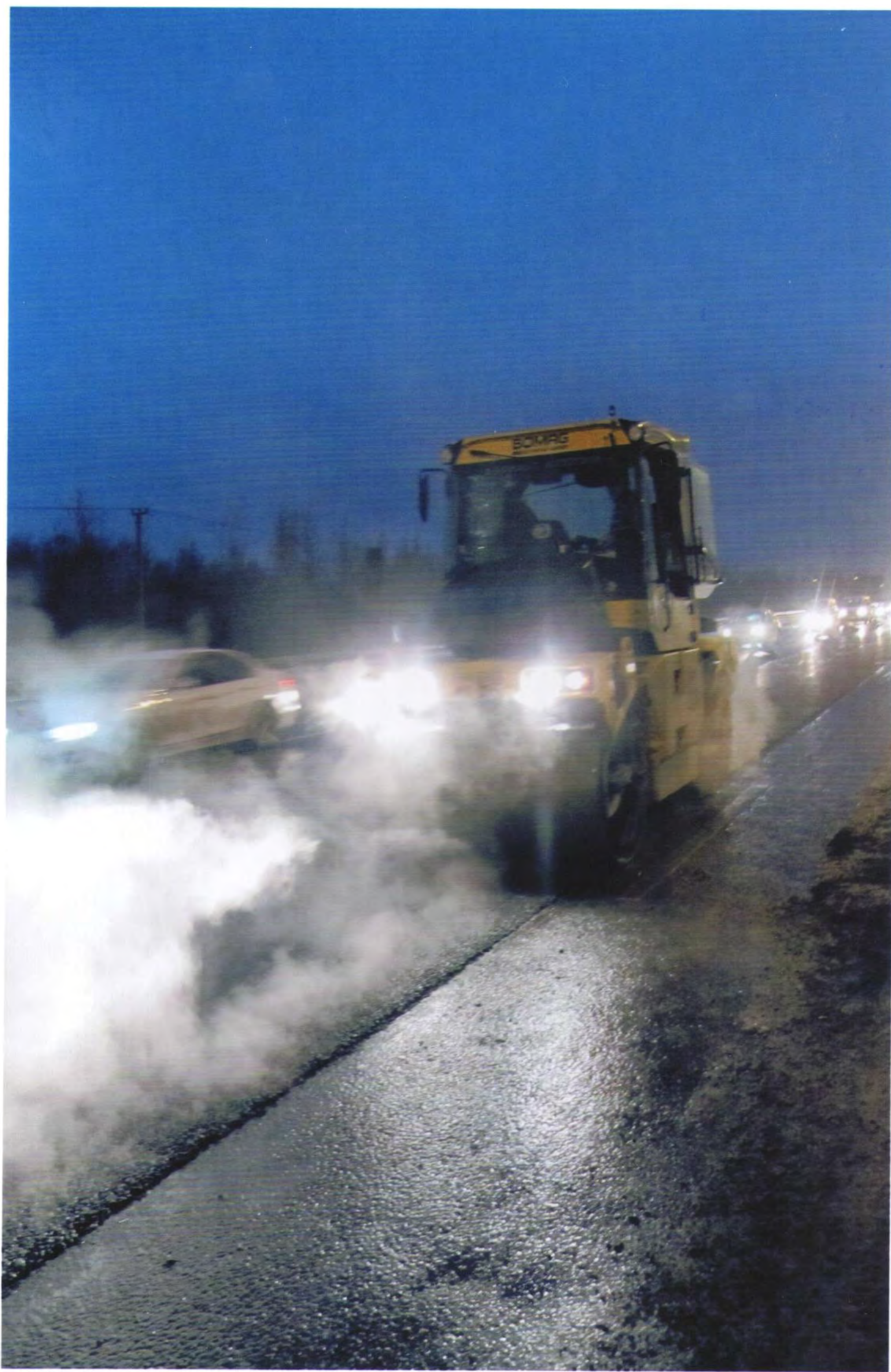
Рис. 13 Выделение испарений при доуплотнении
