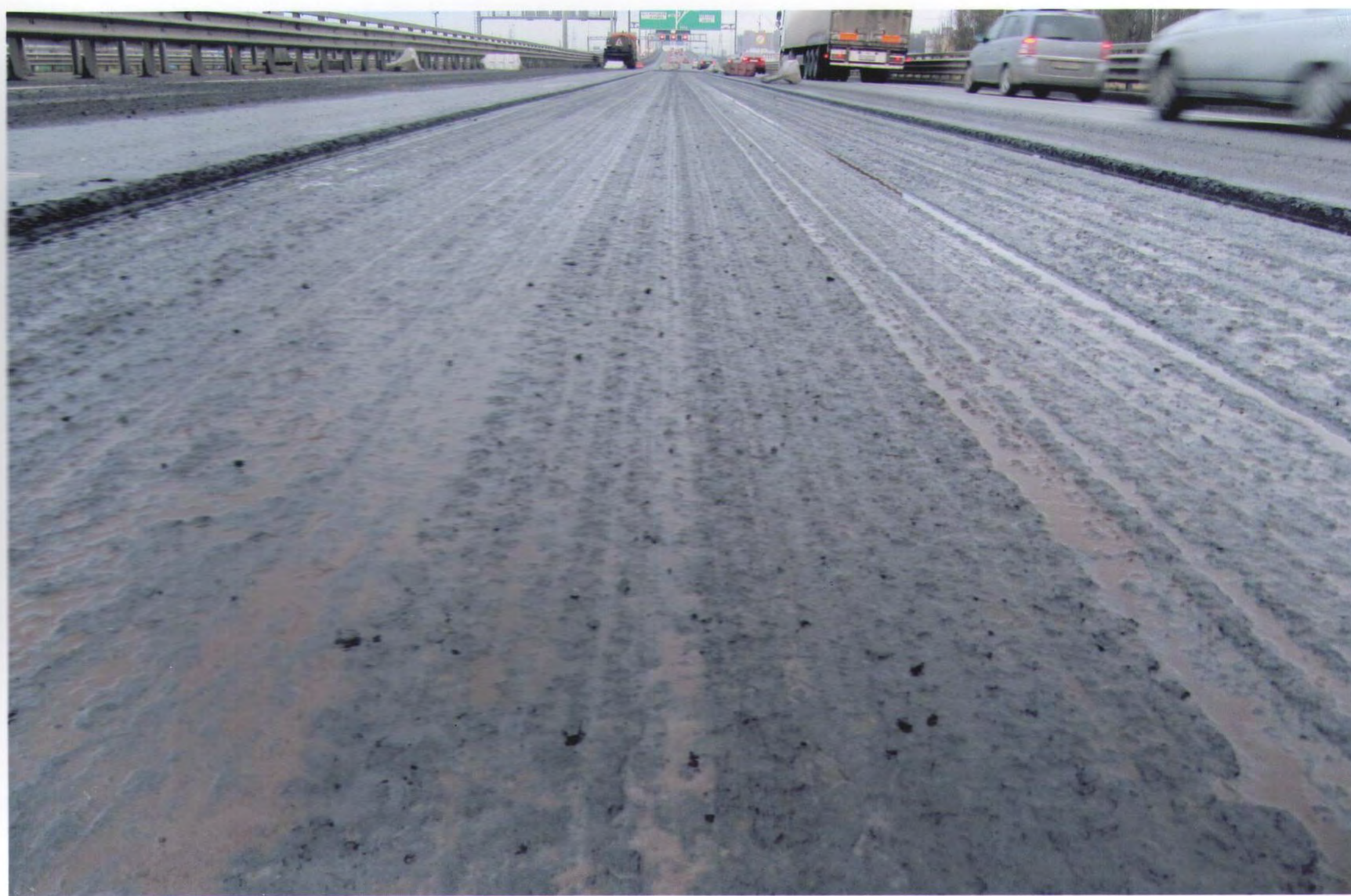
Рис. 2 Состояние нижнего слоя дорожного покрытия перед укладкой верхнего слоя асфальтобетонной смеси, изготовленной с использованием материала «Dorflex®BA».
