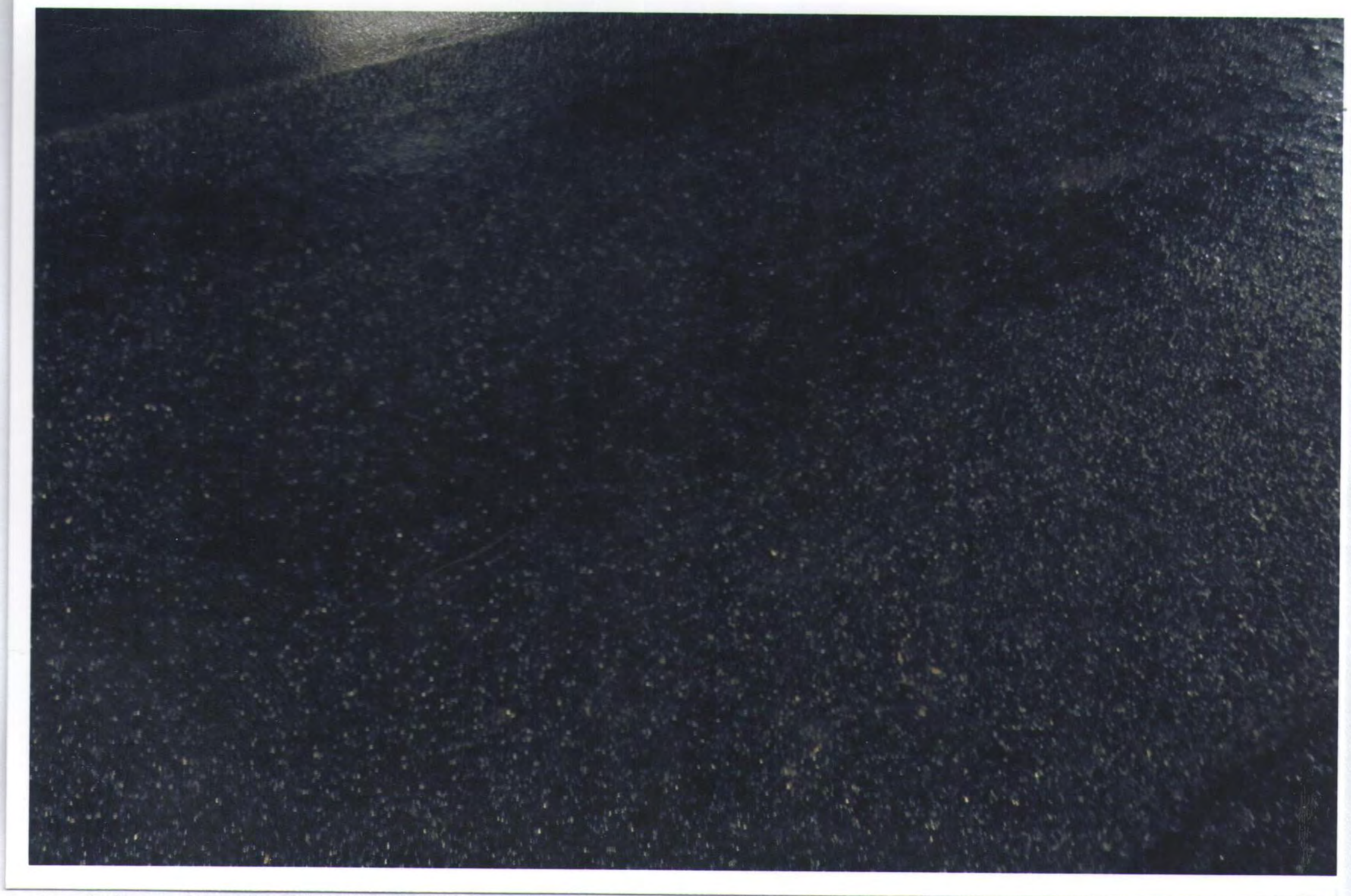
Рис. 16 Крупный план поверхности опытного участка асфальтобетонного покрытия
