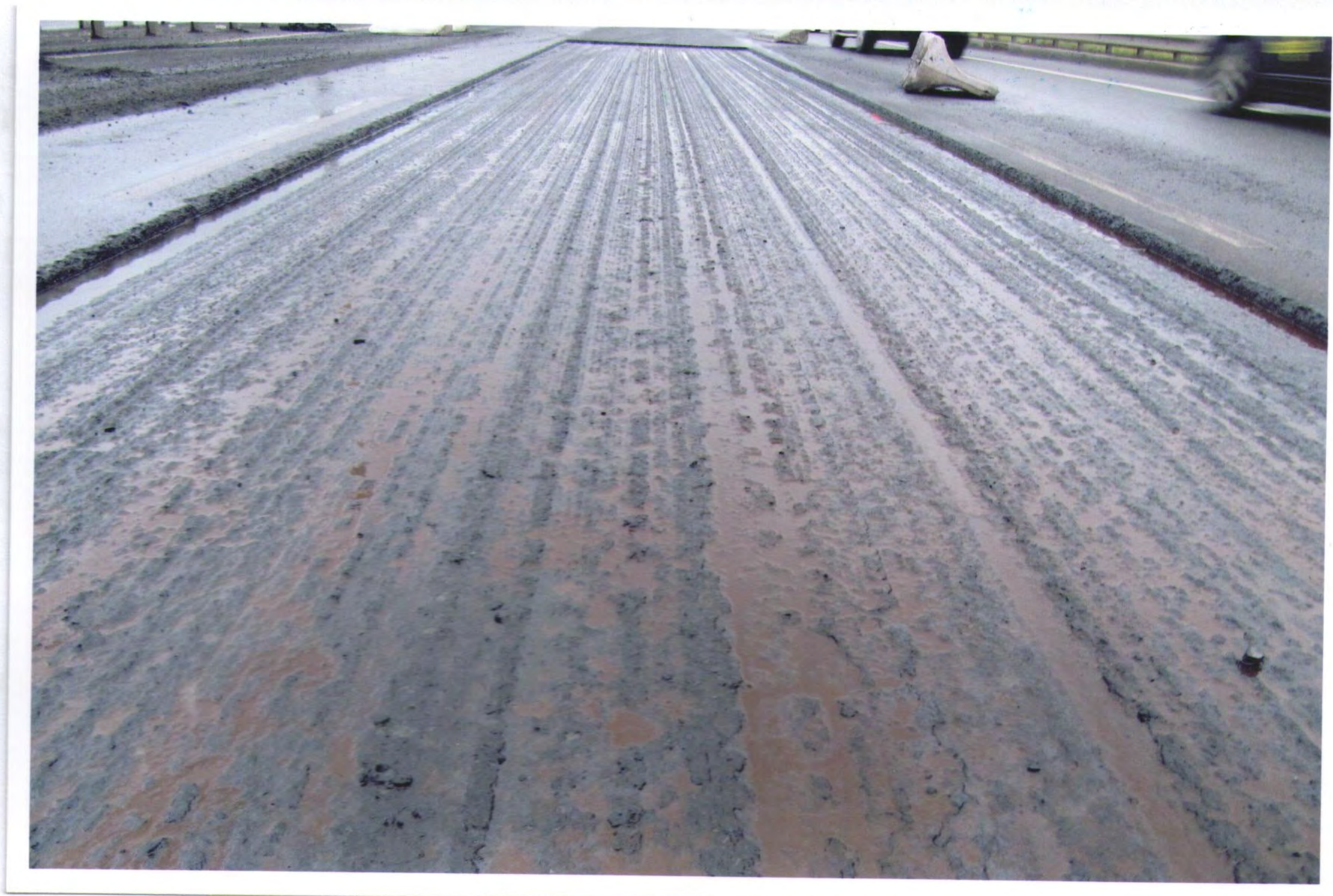
Рис. 17 Состояние поверхности нижнего слоя, на который была уложена опытная партия асфальтобетонной смеси
