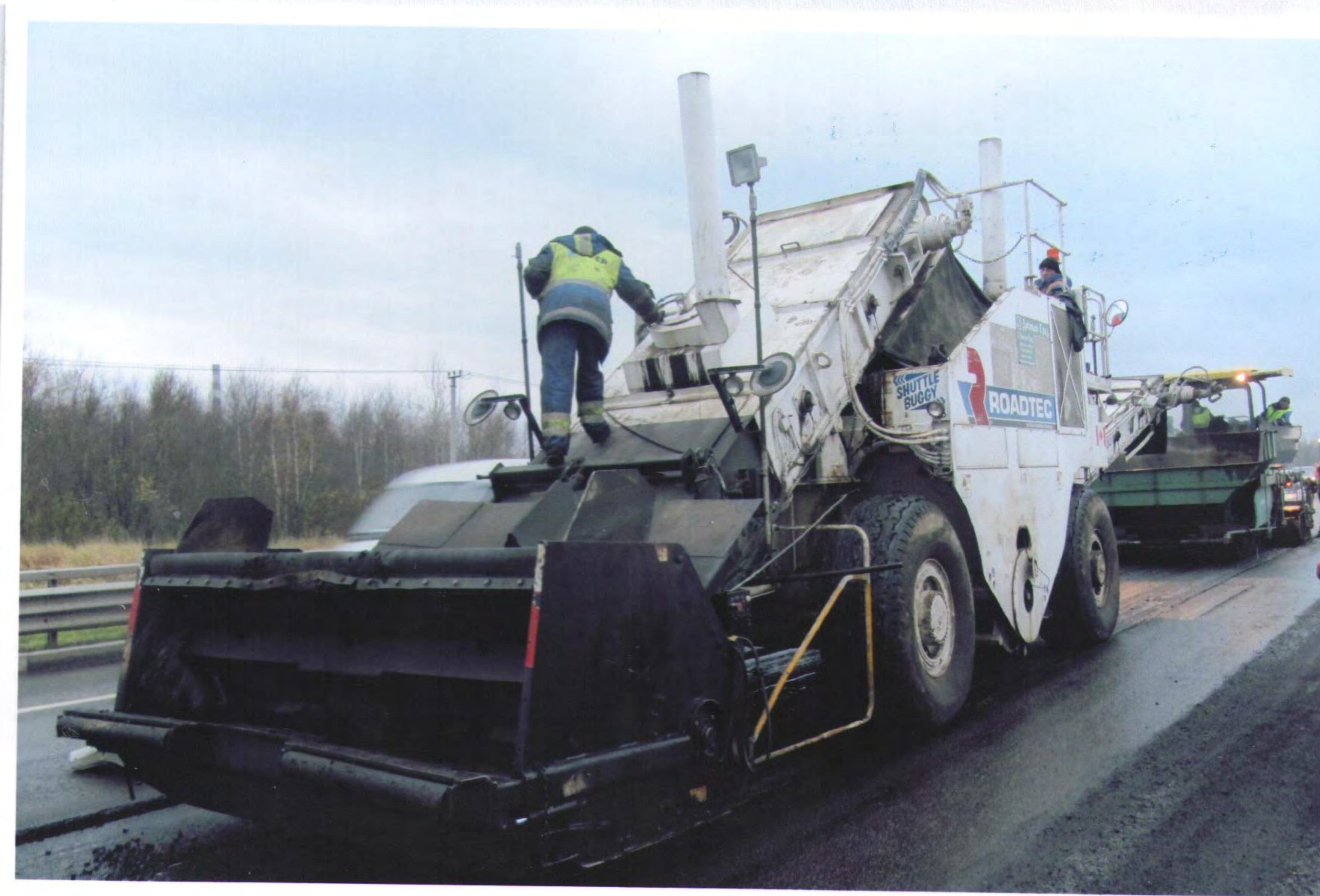
Рис. 3 Укладочный комплекс
