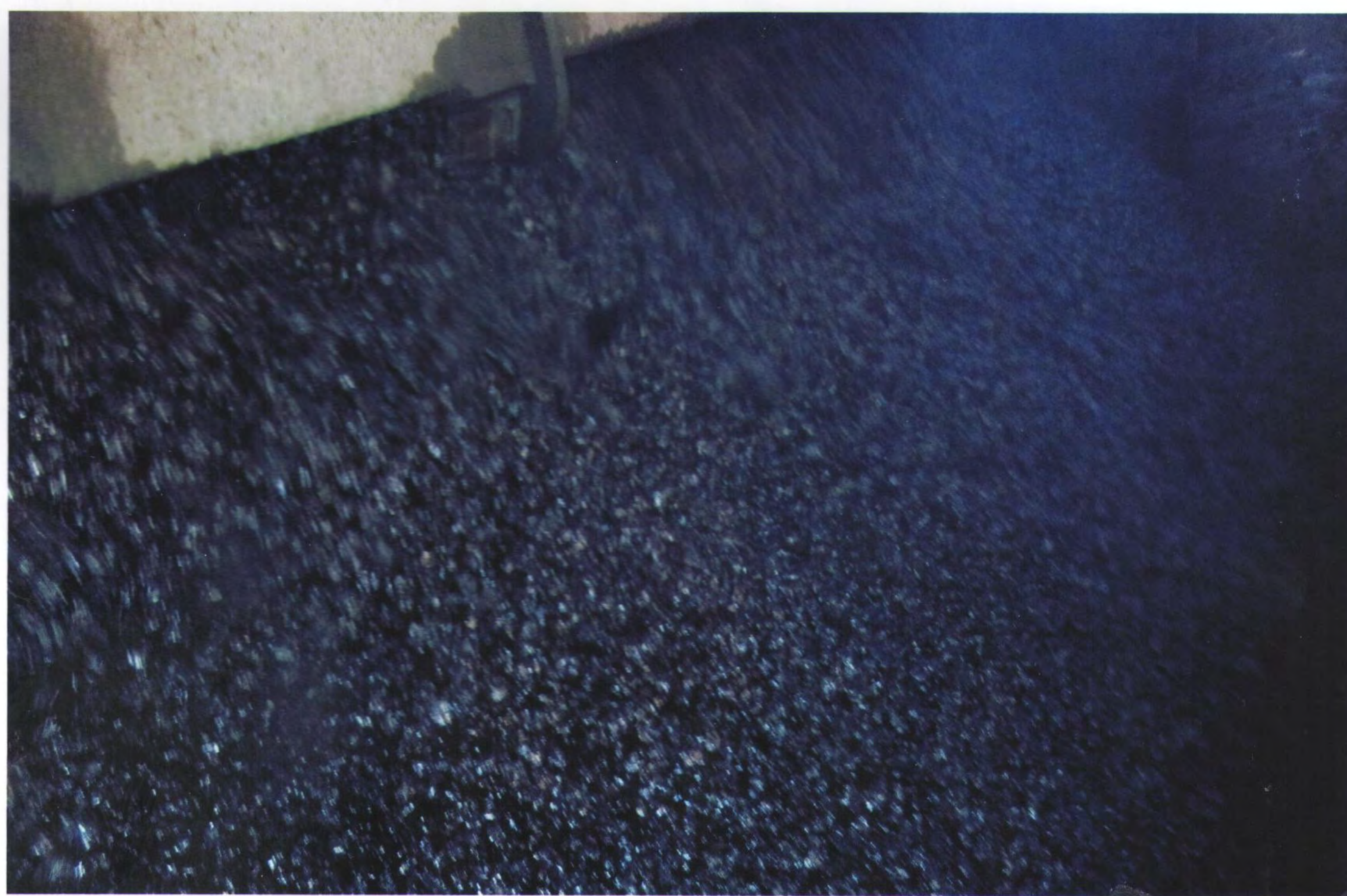
Рис. 6 Асфальтобетонная смесь выгружена в машину «SHUTTLE BUGGY»
